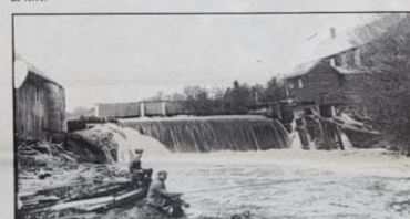
À l'aube des années 1900, deux pêcheurs lancent leur ligne en aval du barrage en quête de truites et brochets, une scène typique à l'époque et que l'on pourrait voir renaître, un siècle plus tard. (Courtoisie de Errol Cushing)
